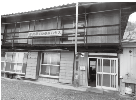
体験施設兼活動拠点の「くわのみハウス」
